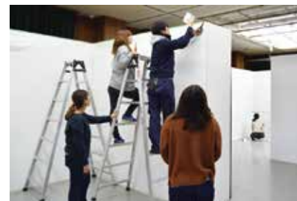
部屋の養生作業
